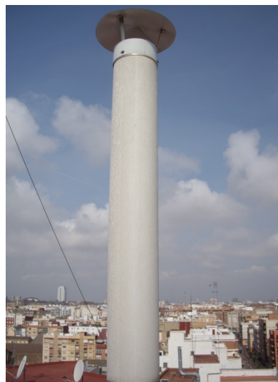
UN TERCER EJEMPLO, MÁS LOGRADO, DE RADOMO DE OCULTACIÓN DE MÁSTIL Y ANTENAS TIPO CHIMENEA
