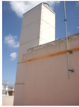
RADOMO CONSTRUIDO POR VODAFONE PARA OCULTAR TANTO EL MÁSTIL COMO LAS ANTENAS DE UNA ESTACIÓN BASE. SE OBSERVA EL ACCESO AL INTERIOR DEL MISMO
