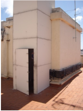
RADOMO CONSTRUIDO POR VODAFONE PARA OCULTAR TANTO EL MÁSTIL COMO LAS ANTENAS DE UNA ESTACIÓN BASE. SE OBSERVA EL ACCESO AL INTERIOR DEL MISMO
